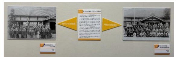
写真3 金属供出前後の写真
